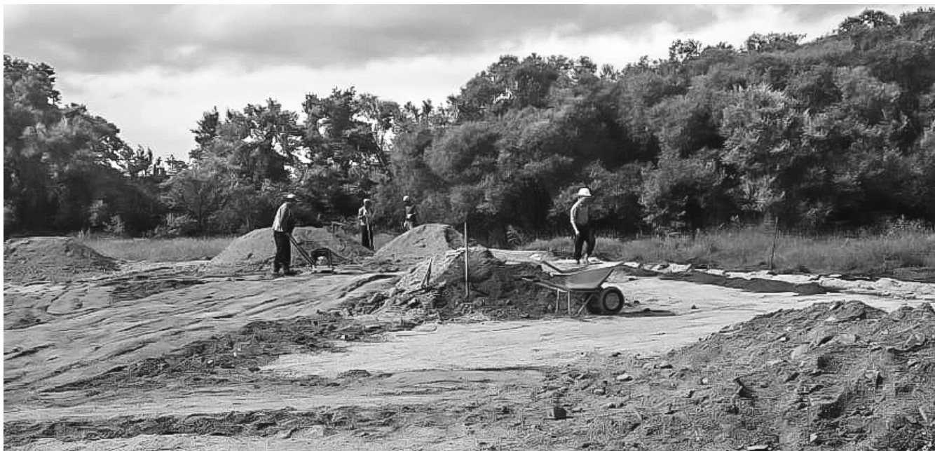
► На сегодняшний день строители занимаются подготовкой основания для будущего каркасного здания пожарного депо
